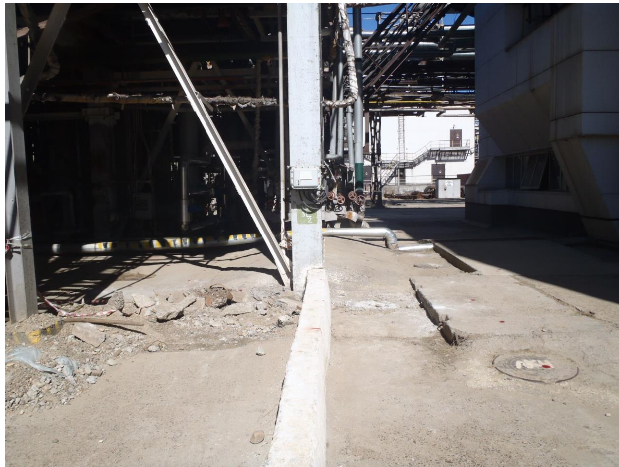
Фотография с участка работ
